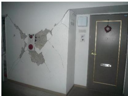
非構造体では、「廊下外壁の亀裂」「玄関ドアの開閉不能」が目立ち、非構造体以外では「タイルの剥離・落下」や「地盤の沈下・陥没」が多い。
