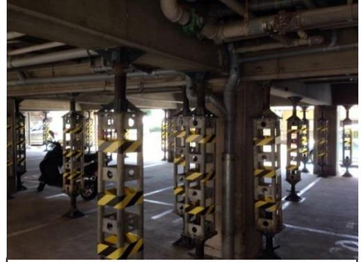
高層 旧耐震マンションが小破の判定で継続居住。ピロティ柱はひび割れにとどまった。
