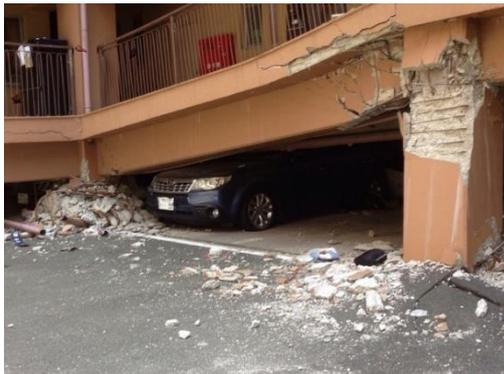
高層 旧耐震マンションはピロティが層破壊し倒壊の判定。
