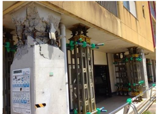
市営中層住宅 新耐震だが中破の判定。ピロティ柱は損壊。
