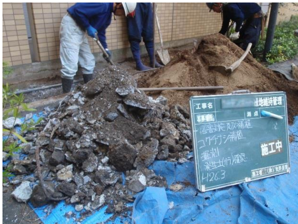
写真3) 縁石天端 25 cm以下掘削
