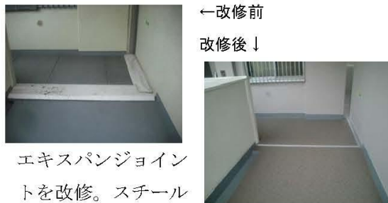
床段差5cm解消（廊下・階段調整）
