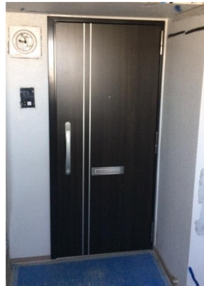
3/10カバー工法による玄関ドア
