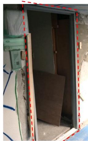
1/10耐震ドア枠へ交換
