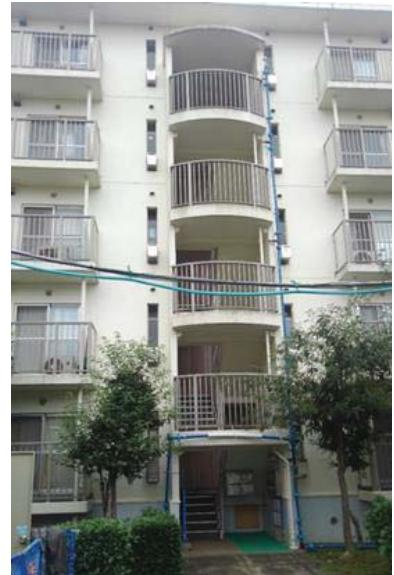
マンション給水管改修工事における仮設配管資材レンタルシステム「リユーズV」
