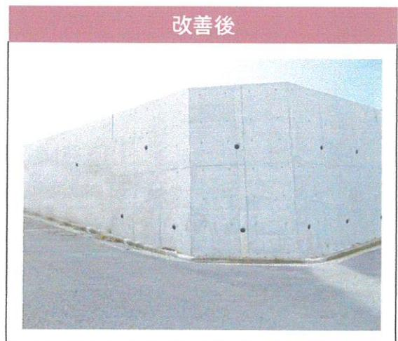
鉄筋コンクリート造（RC造）擁壁に改善
