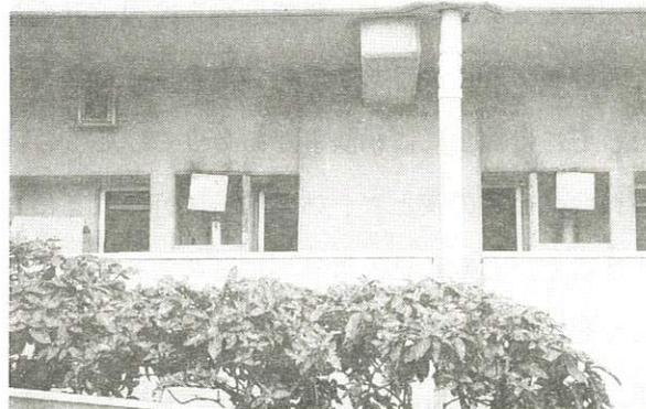
ハ・塔屋（エレベーター機械室）の外壁か換気ガラリ廻りからの漏水が原因で、下階の天井に雨漏りがある。漏水場所は特定できないので詳細調査の上修理の必要あり。屋根防水も旧改修の防水層の破断が見られる。修繕の必要があるかは現在漏水事故の発生があるか調査する事、無ければ緊急の修繕は必要ない。
