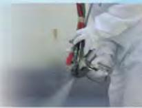
「超速硬化」のウレタン塗膜を「スプレーで成形する」超速硬化ウレタン吹付けシステムのパイオニア。塗布後短時間で実用強度を得ることができため、作業時間を大幅に短縮できる。複雑な形状にも連続的に施工が可能。
