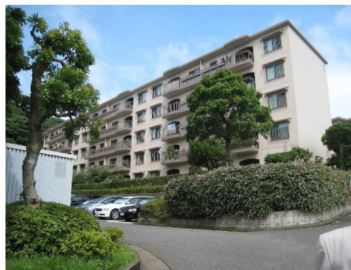
↑高経年団地型マンションの例 再生に向けての企画書作成 長期修繕計画見直し業務 屋上防水改修工事及び 給水方式改良工事の 設計・監理業務
