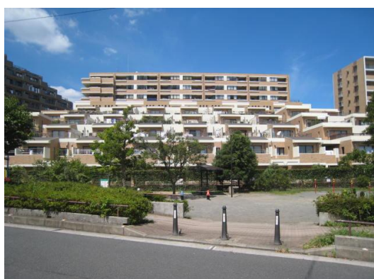
↑中低層3棟からなるマンションの例 大規模修繕工事の設計・監理 長期修繕計画の見直業務
